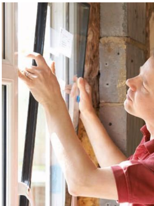
Figure 7 : Travaux d'installation de vitrage acoustique
