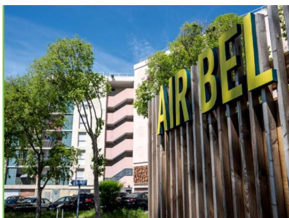
Figure 15 : Le quartier Airbel fait l'objet d'un projet de requalification dans le cadre du Nouveau Plan National de Renouvellement Urbain au travers duquel l'exposition de la population au bruit des infrastructures a été prise en compte.
