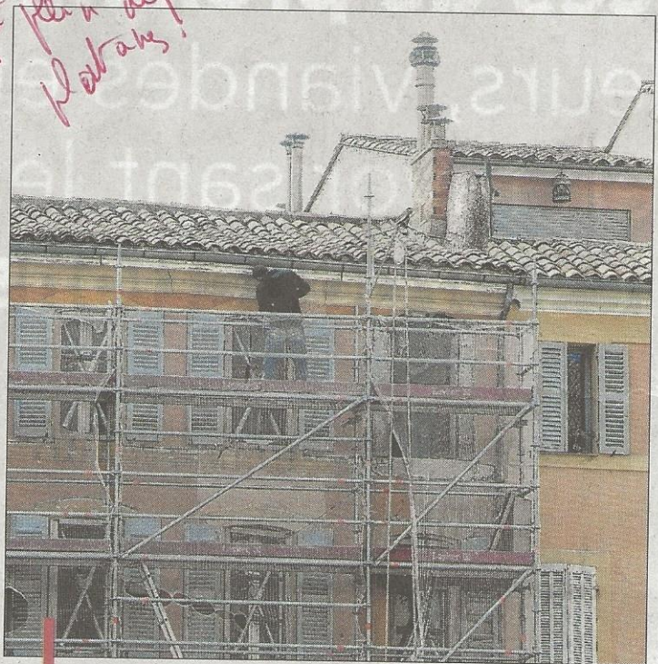
Les travaux effectués sur le dernier immeuble concerné par l'arrêté de péril ont démarré la semaine dernière. /PH. CYRIL SOLLIER
